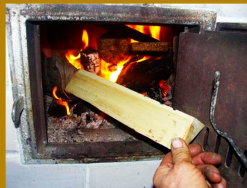
Размер дров должен соответствовать размерам топливника
